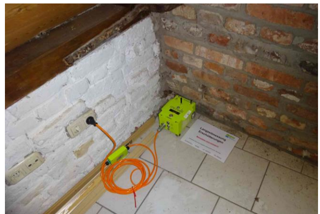
Abb. 2: Position eines Messgerätes auf der obersten Deckenebene (Beispiel)
