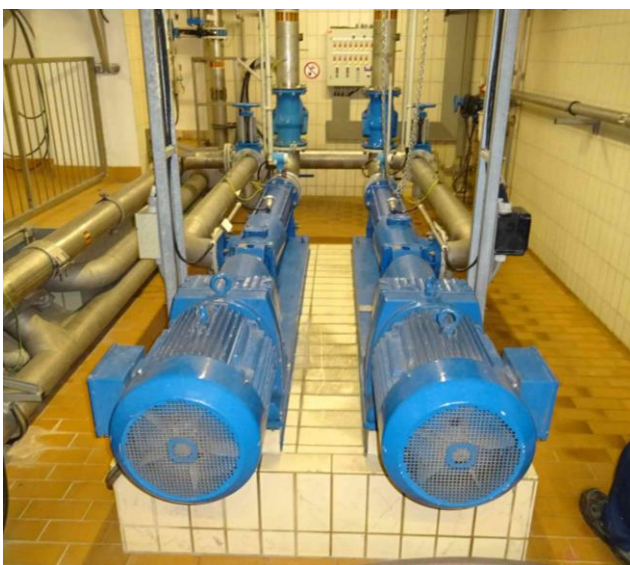
Abb. 1: Untersuchte Exzentrerschneckenpumpen im Klärwerk
